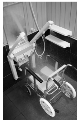
改修例 「冬も寒くないシャワー・ド・バス」
